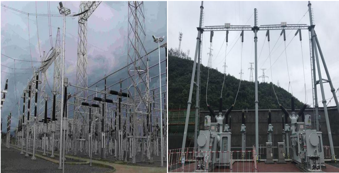
AIS 布置模式（前）与 GIS 布置模式（后）示意图
