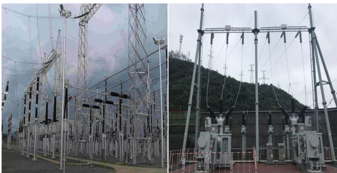
AIS 布置模式（前）与 GIS 布置模式（后）示意图
